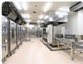
焼き物・揚げ物室
